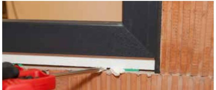
6: Fixierung des Fensterbretts durch Verschraubung in das COMPACFOAM Material
