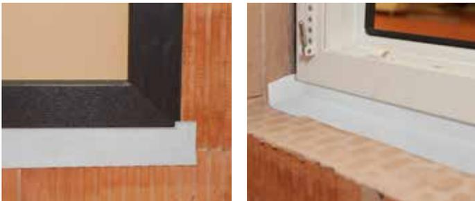
2: Positionierung des Fensterrahmens auf den Montageklötzen
